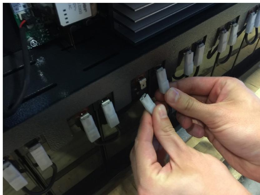
Рисунок 6 – Электрическое соединение батарей с помощью перемычки
