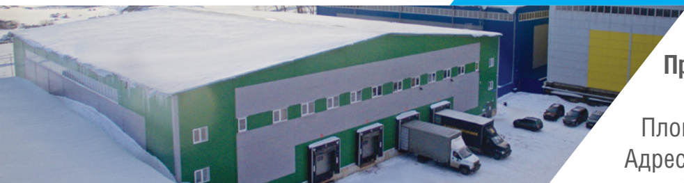
Производственная площадка в Ленинском р-не, Московская обл.
