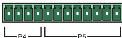
Рис. 4-7. Сухие контакты батареи
