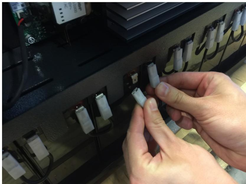
Рисунок 10. Электрическое соединение батарей с помощью перемычки
