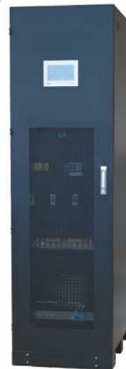
Силовой кабинет АБП
